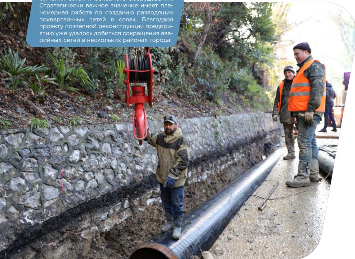
Специалисты успешно завершили строительные работы по прокладке современных полимерных трубопроводов по ул. Турчинского, от перекрестка с ул. Заповедная до отеля «Лазурная» заменено более одного километра водовода диаметром 150 мм. Аналогичный объем работ по модернизации сетей был проведен и на сетях меньшего диаметра по улице Дальней, а также ул. ГЭС и ул. Гидростроителей.
